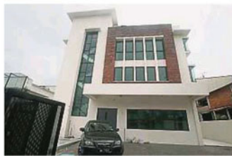
▶位于SS2/24路及SS2/59路的美门总部和残障领袖培训中心大楼工程目前还在等待完工及符合证书（CCC），获得有关证书后即可进行装修。
